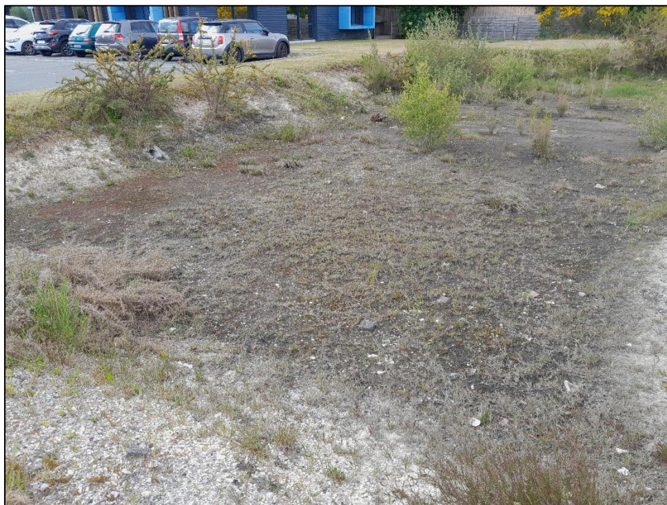
Photographie 26 : Prise de vue rapprochée du bassin existant à l'ouest de S2 (hors emprise projet) (06/05/2025)
