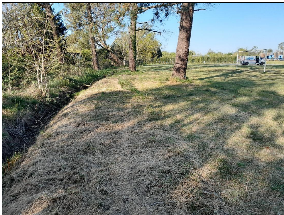
Photographie 12 : Prise de vue du sud de S8 vers S4 (10/04/2025)
