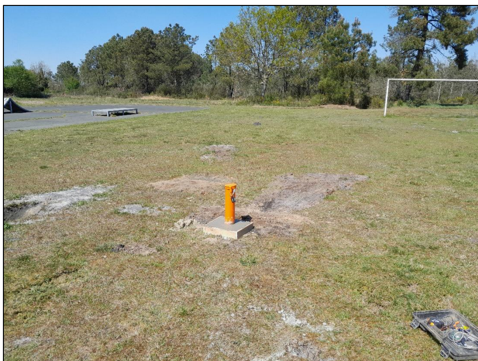
Photographie 15 : Prise de vue du piézomètre posé le 10/04/2025 depuis le sud-est (10/04/2025)
