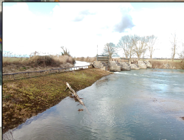
4) Vue du déversoir et des vannages depuis l'aval rive droite (26/02/2024)
