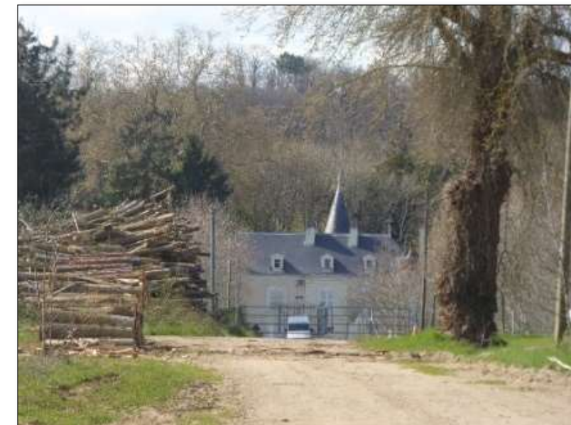
Figure 17 : Les Grands Villiers en entrée de site
