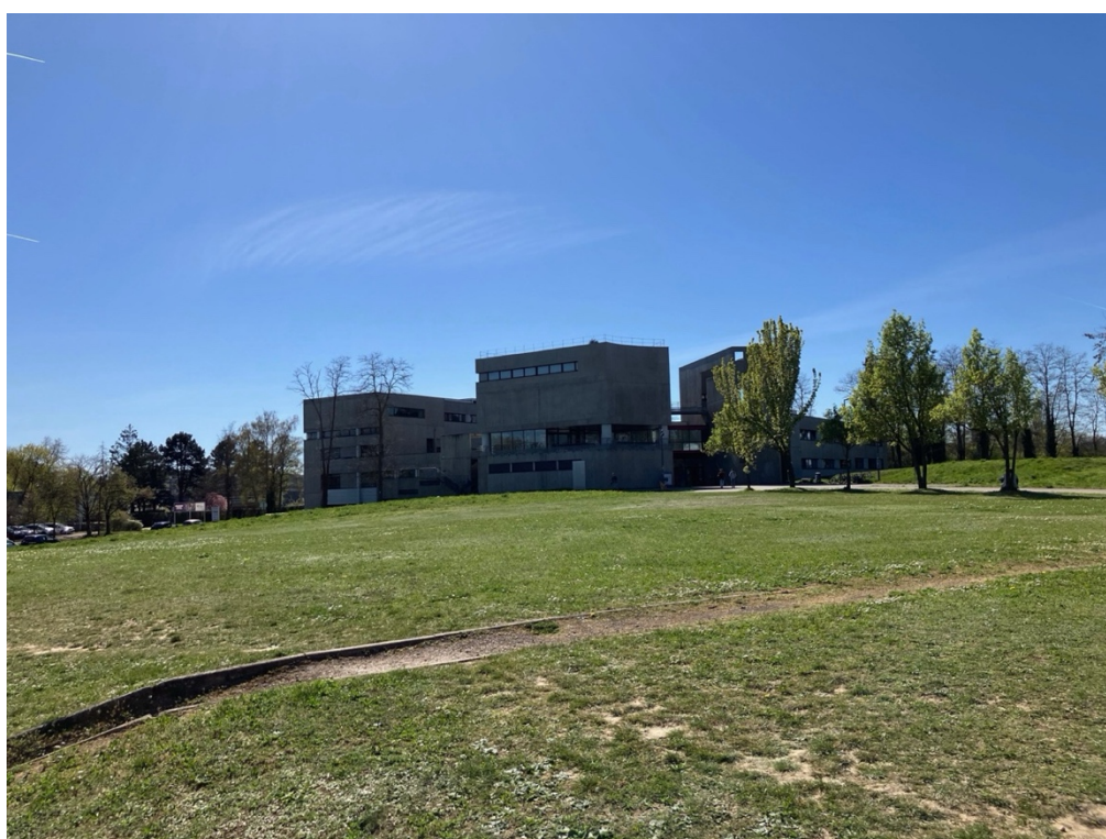
Illustration 7 : Vue vers la FST de Mulhouse – Source ARCHIMED Environnement – 07/04/2026 - Fig. 6
