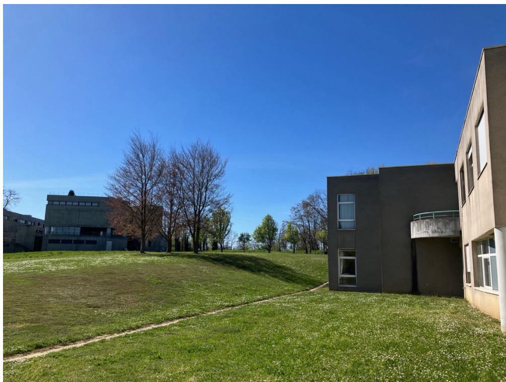
Illustration 4 : Vue vers la FST depuis la MIAGE – Source ARCHIMED Environnement – 07/04/2026 - Fig. 3
