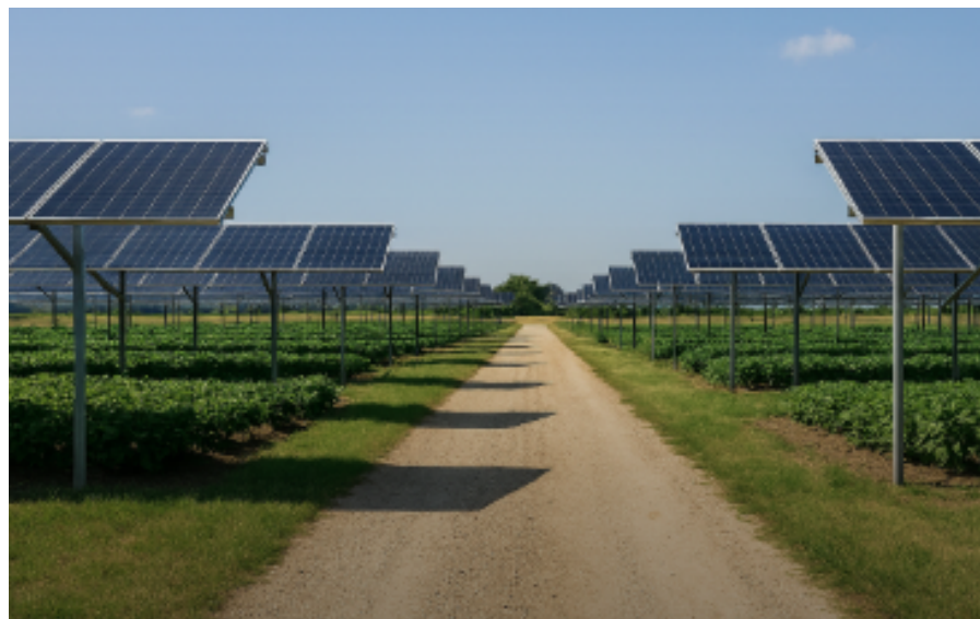
Figure 16 16 : exemple de pistes d'exploitation en grave non traitée
