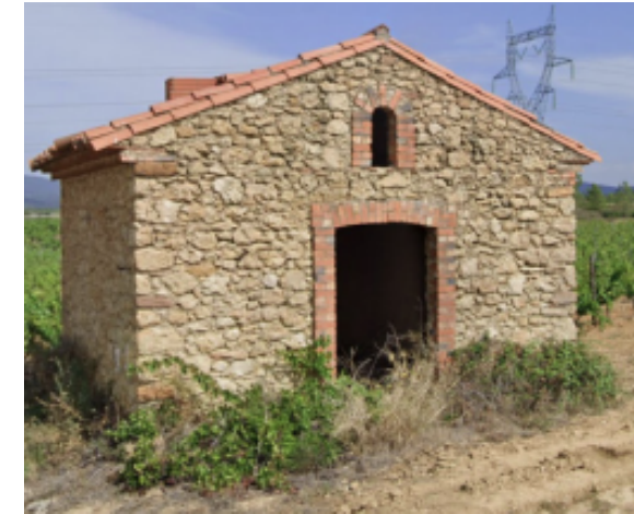
Figure 15 15 : visuel d'une maison de vignes de l'Hérault à reprendre pour le bardage du poste
