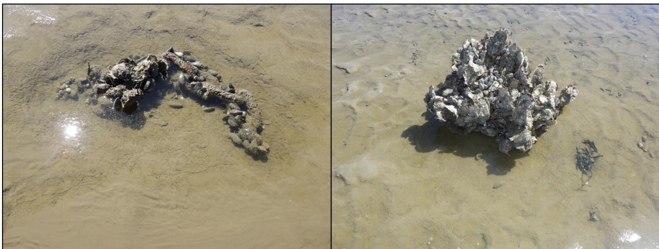
Figure 13 : Mouillages composés de chaînes recouverts d'épiphytes (ici moules et huîtres) © TBM environnement 2025.
