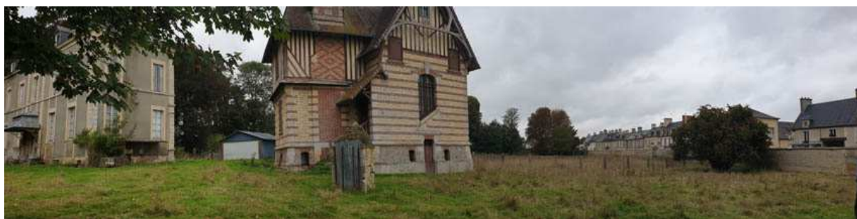
Vue sur le Pavillon de Chasse et le Château de la Garde, conservés dans le cadre du projet
