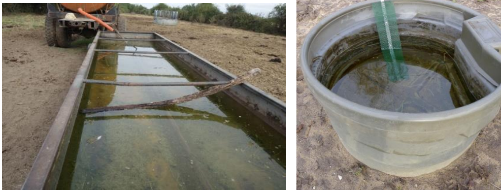
Figure 51 : Exemples de dispositifs anti-noyade installés dans des points d'eau de chantier.
