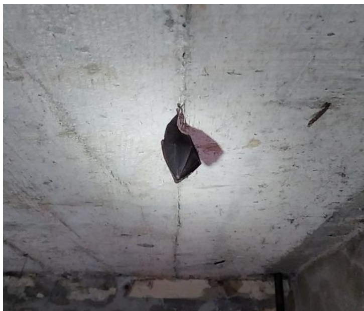
Figure 27 : photographie tirée du rapport du pré-diagnostic de IAO SENN, 2022 dans le bâtiment 5 (Source : ETAMINE).
