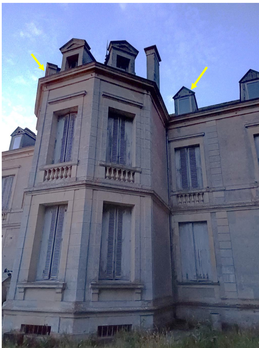
Figure 33 : Photo de la facade ouest du château et points d'entrée des Sérotines communes dans les combles (flèches jaunes)
