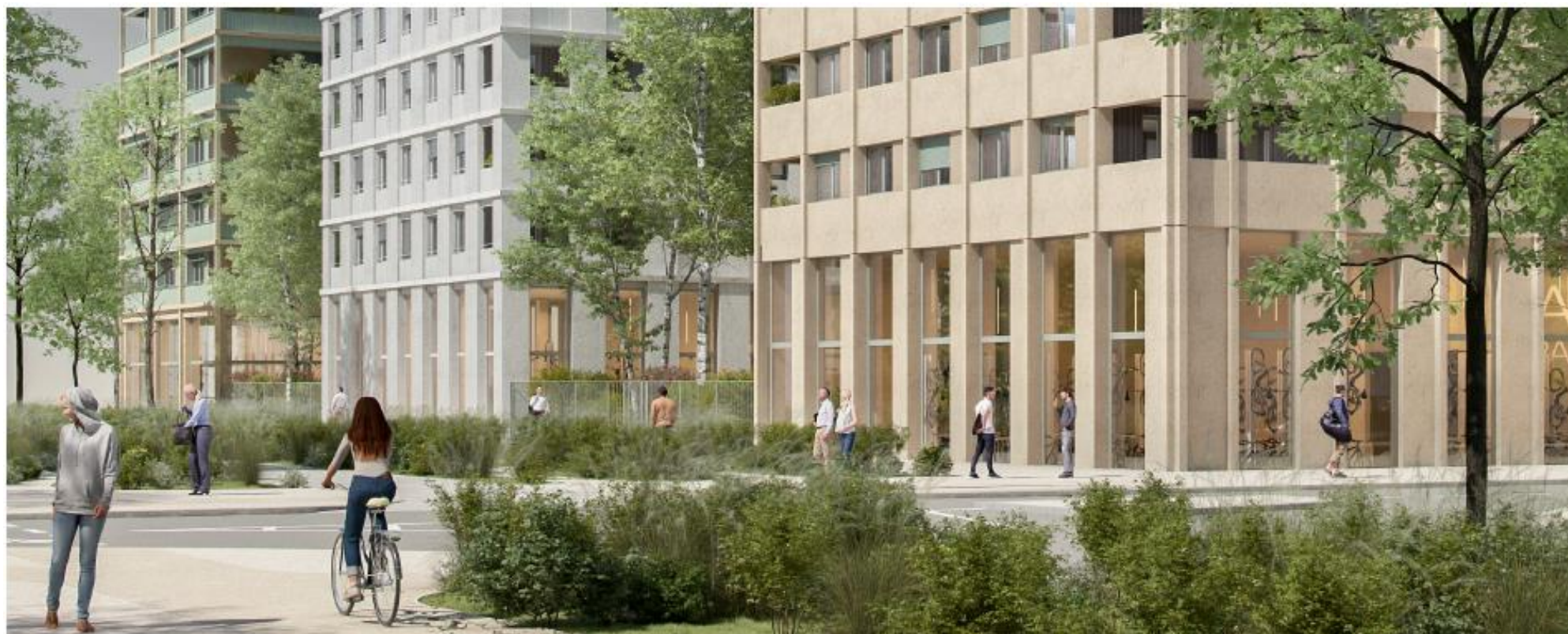
Vue des accès et des locaux vélos depuis Avenue G. de Monnerville
