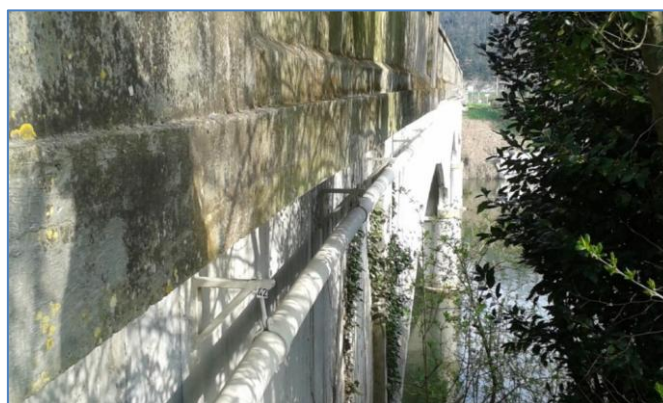
Traversée de la Dordogne en encorbellement
