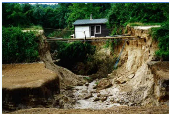
Effondrement de mai 1996 : vidange du canal et mise à nu de la canalisation
