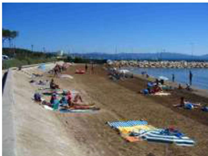
Photo 1 : Plage de 10m de profondeur après rechargement par pompage de sédiments marins - Août 2005
