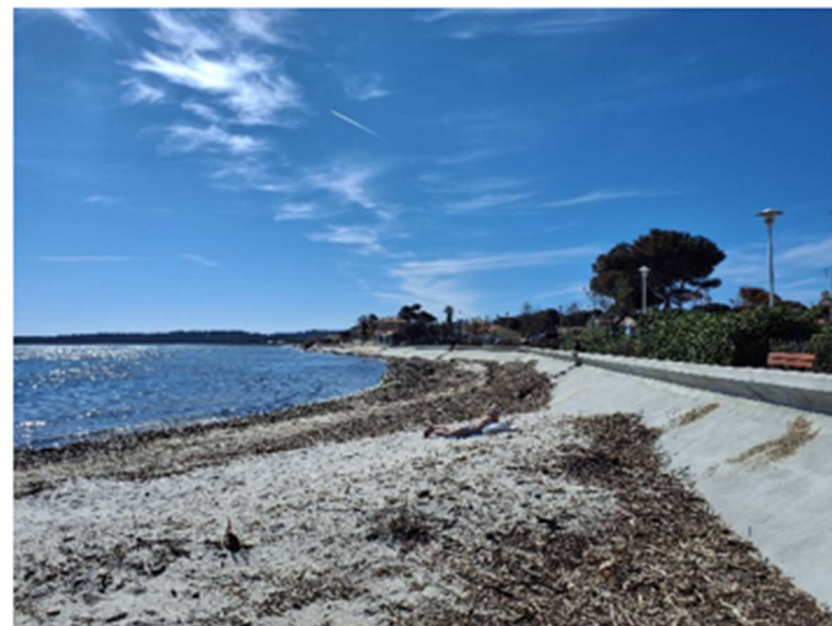
Photo 7 : Plage et mur de contrefort haut de plage - Mars 2026
