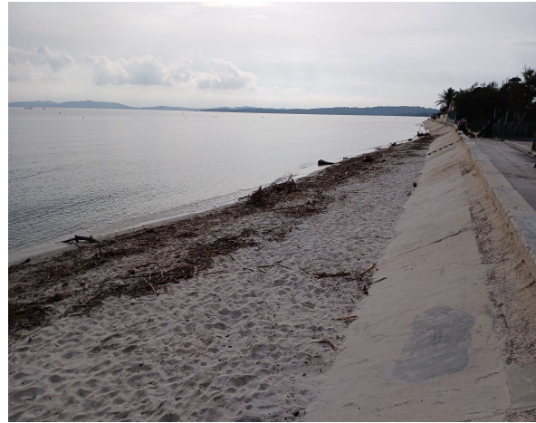
Photo 6 : Plage et mur de contrefort en haut de plage - Février 2026
