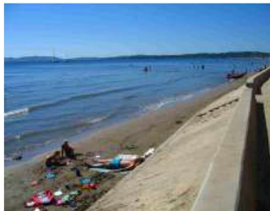
Photo 2 : Plage de 5m de profondeur au droit du parapet en béton et après rechargement par pompage - étude CETMEF - Août 2005
