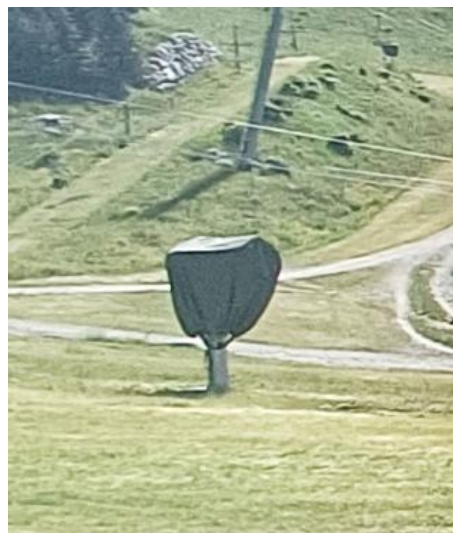
Enneigeurs du front de neige Ouest d'Orcières recouvert par des bâches en période estivale. Source : KARUM, 2023.
