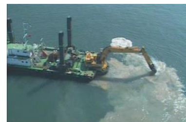
Phénomène de dispersion de MES lors de travaux maritimes
