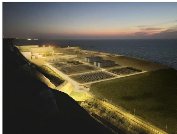
Vue nocturne du site de Penly pendant le chantier
