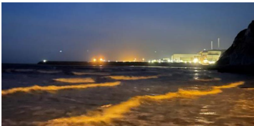
Vue nocturne du site de Penly depuis la plage de Saint-Martin-en-Campagne
