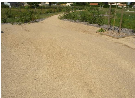
Stabilisé type chape granitique locale ou calcaire (entrée du château)
