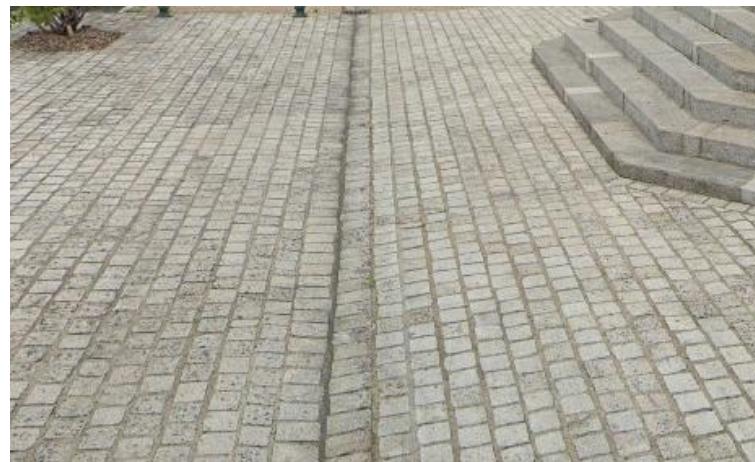
Pavés en granite existants, repose par endroit des mêmes
