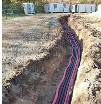
Figure 5 : Photographie des tranchées réalisés pour un projet de Corsica Sole
