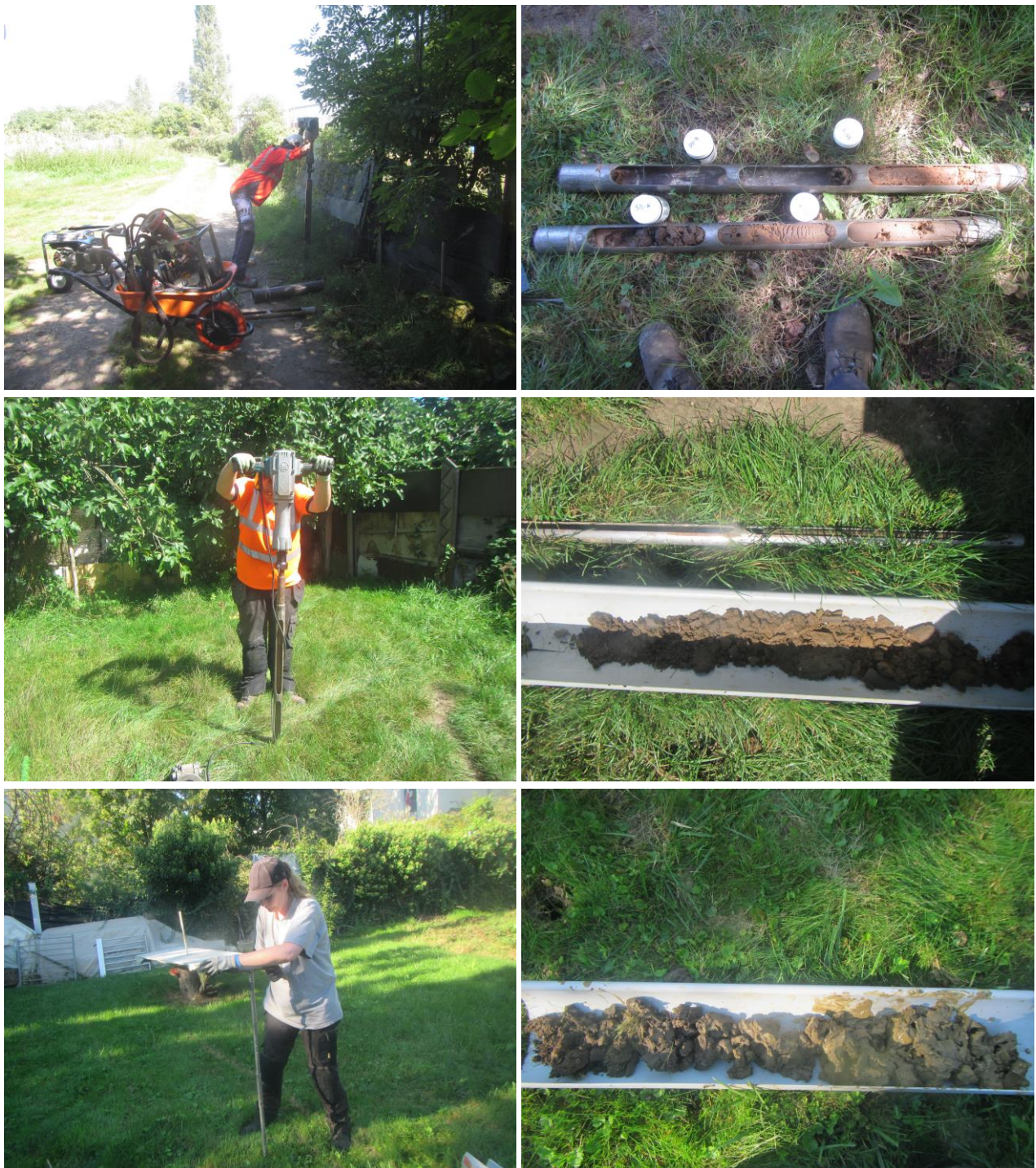
Figure 11 : Technique de forage au carottier portatif (ATME et IXSANE) et à la tarière manuelle (IXSANE)
