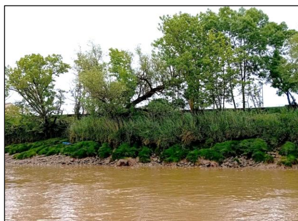
Figure 22 : Enrochements visibles en pied, et sous-cavement important sous la ligne de saules / Hydrophytes en cours d'installations sur la zone d'enrochements
