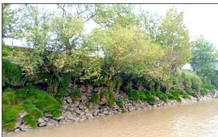
Figure 22 : Enrochements visibles en pied, et sous-cavement important sous la ligne de saules / Hydrophytes en cours d'installations sur la zone d'enrochements
