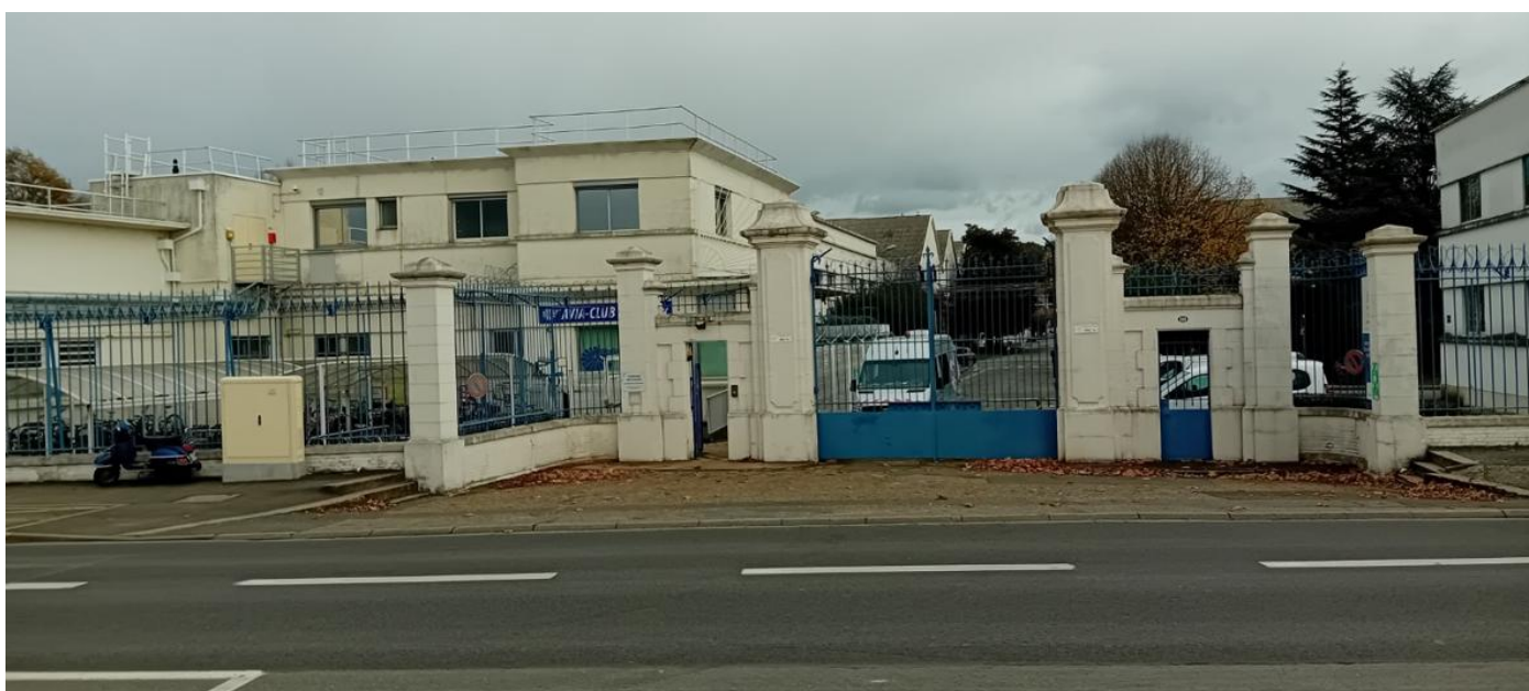
Figure 85 : AIA de Bordeaux - accès principal
