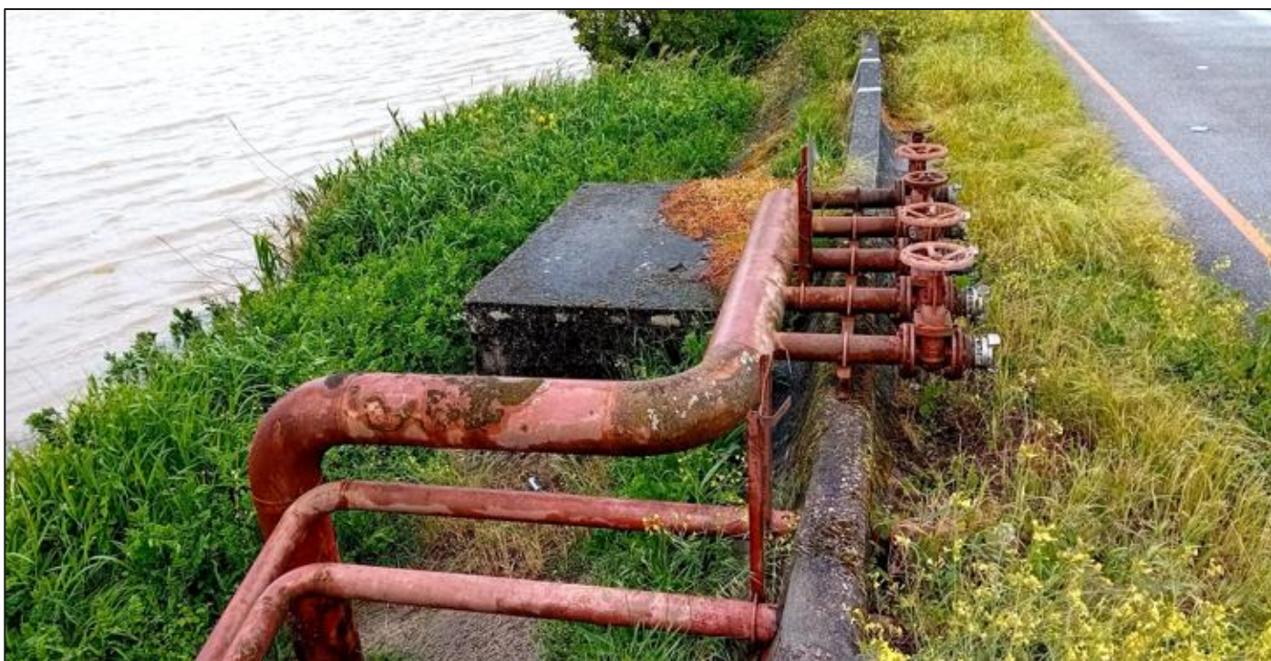
Figure 96 : Anciennes conduites de pétrole et vannes de déchargement
