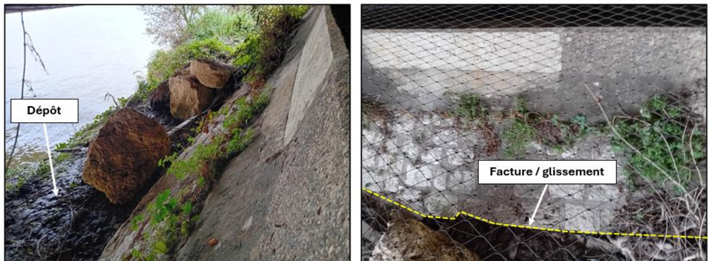
Figure 51 : Perré et berge sous le tablier
