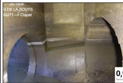
Conduite bon état / neuf, sans dépôts
