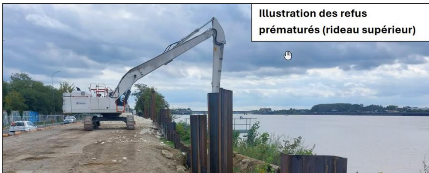
Figure 100 : Pelle long bras utilisée lors des travaux d'urgence
