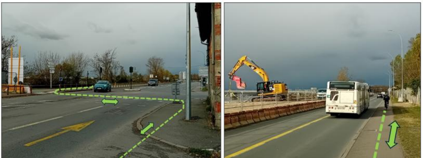
Figure 86 : Déviation de la piste cyclable sur les travaux d'urgence
