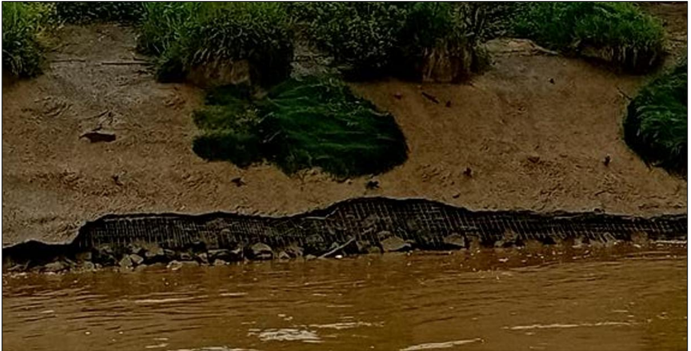
Figure 11 : Etat du confortement 2006 -photo avril 2025
