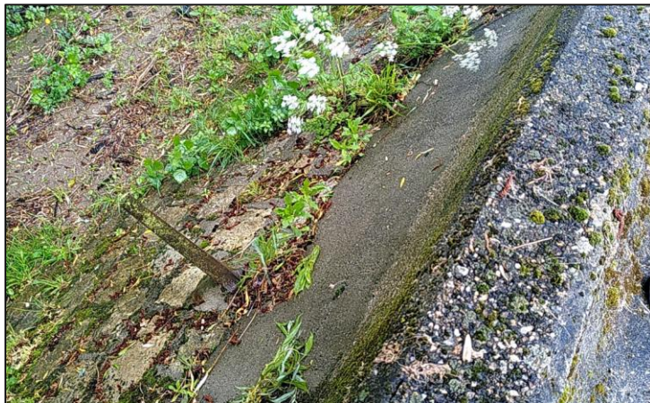
Figure 27 : Exemple de la limite Perré maçonné / mur en béton
