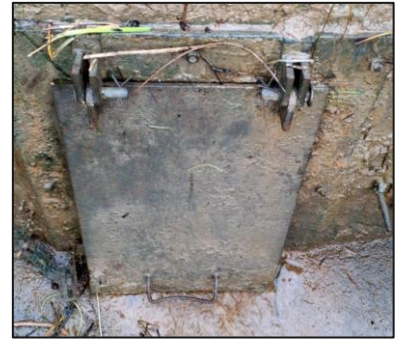
Clapet sortie – état moyen
