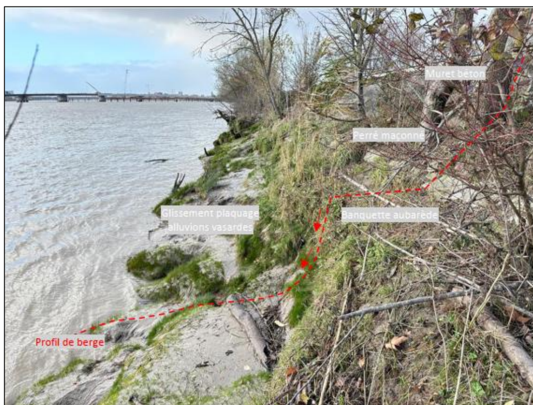
Figure 24 : Synthèse de l'état de la berge (source ANTEA)
