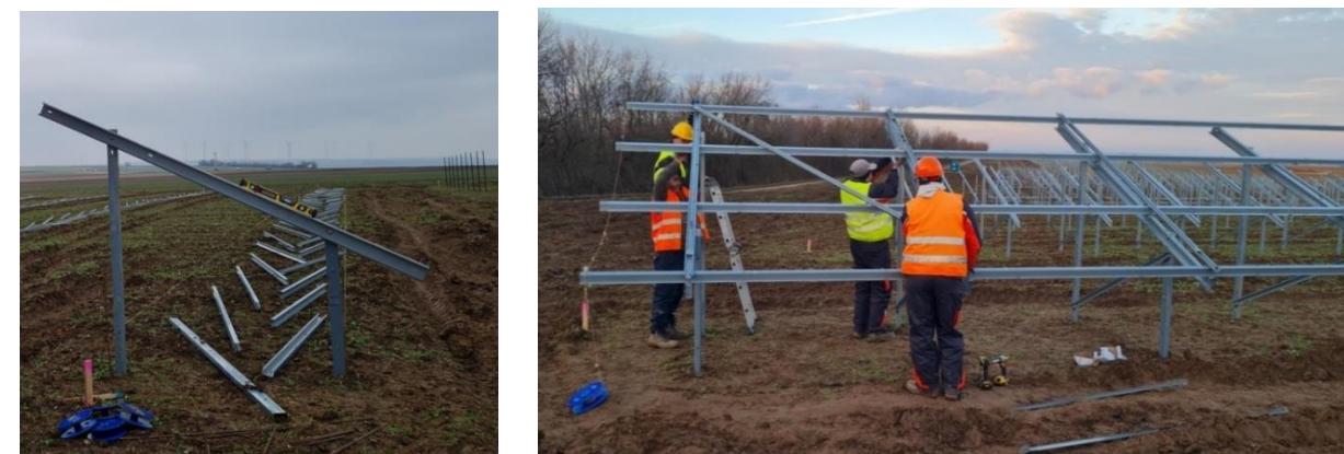
Figure IV-6 : Assemblage des tables photovoltaïques
