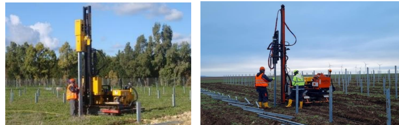
Figure IV-5 : Battage de pieux
