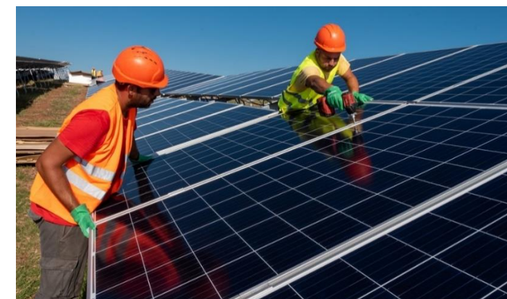
Figure IV-7 : Pose des modules PV sur les tables
