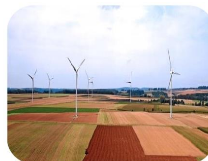
Parc éolien (6) à Maisnières dans la Somme (80) – Puissance de 12MW
