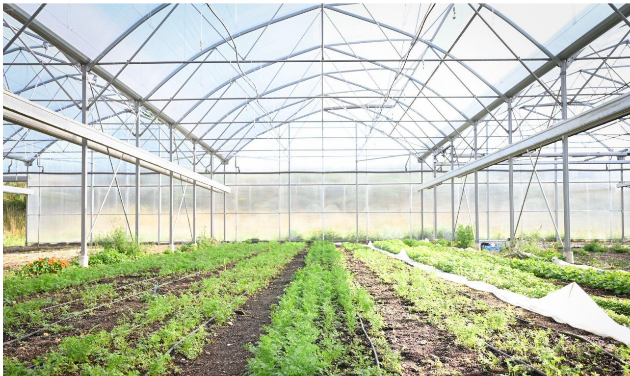
Figure 4 : Exemple de l'intérieur d'une serre NéoFarm
