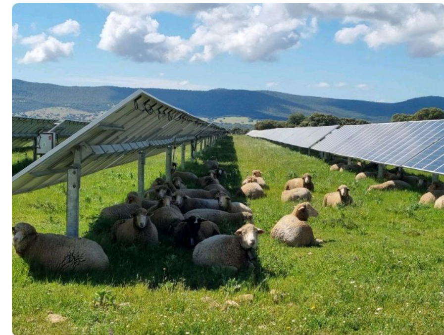
Figure 4 : Modules photovoltaïques de type trackers, à l'orientation réglable.
