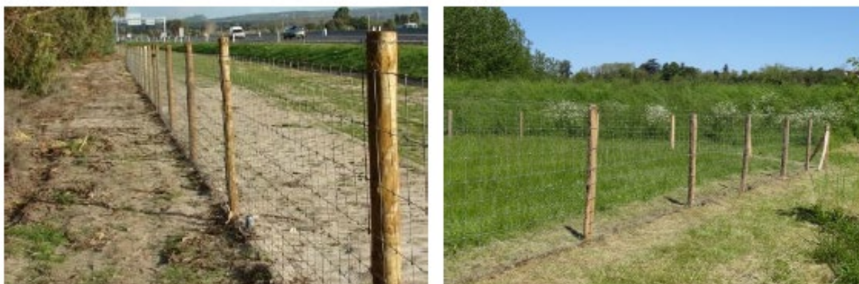
Figure 23 : Exemple d'une clôture de parc solaire
