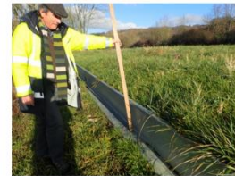
Photo 34 : Collecteur métallique (0,40 m en acier) avec pied empêchant le développement de la végétation, et qui facilite l'entretien et le déplacement des animaux. Exposés au soleil, les pieds métalliques peuvent toutefois devenir très chauds pour les juvéniles et entraîner un risque de dessiccation (Source : © A. Morand, Cerema Est)
