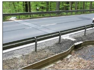
Figure 13 - Exemple de crapauduc à mettre en place de part et d'autre du projet d'aménagement
