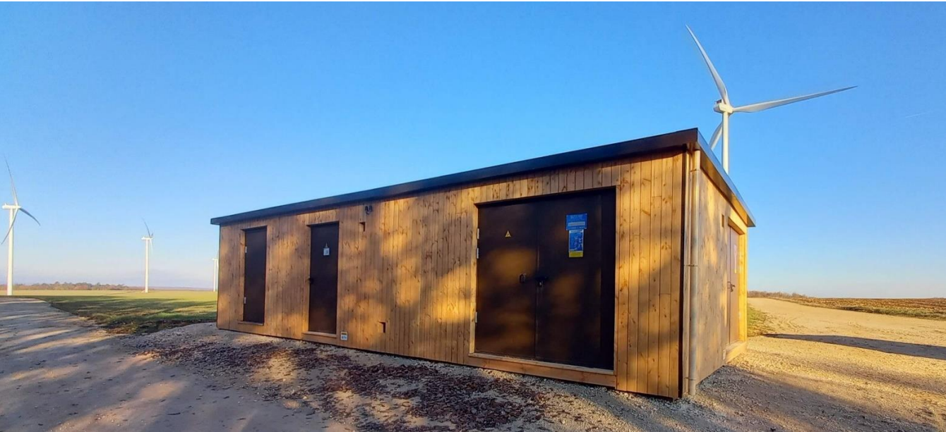
Intégration paysagère du poste de livraison
