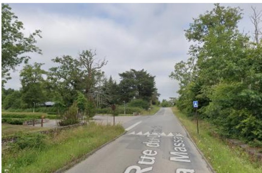
Photo 39 : aménagement accès ZAC sur la D776 (vue depuis l'est)
