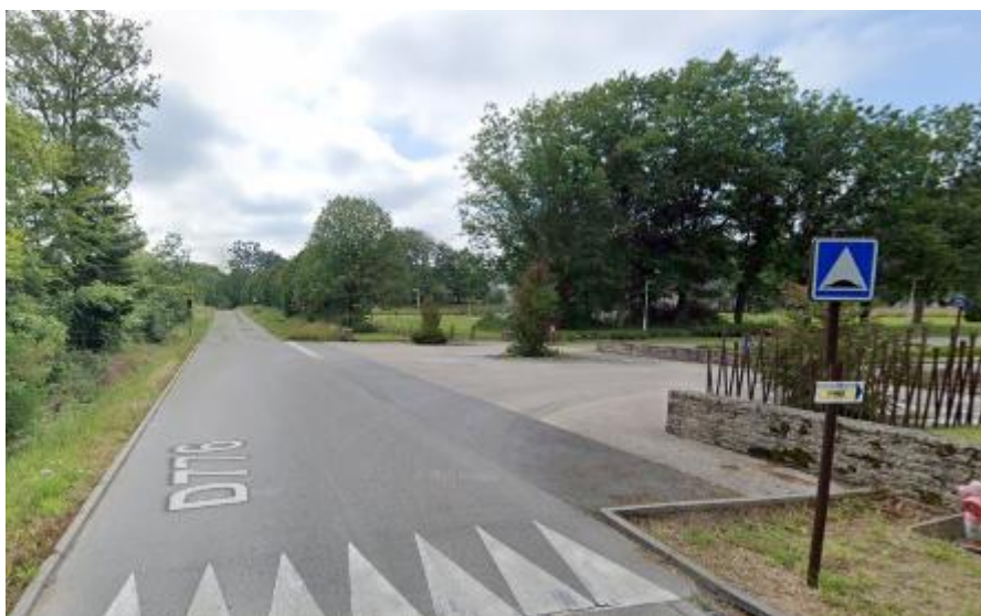
Photo 40 : aménagement accès ZAC sur la D776 (vue depuis l'ouest)
