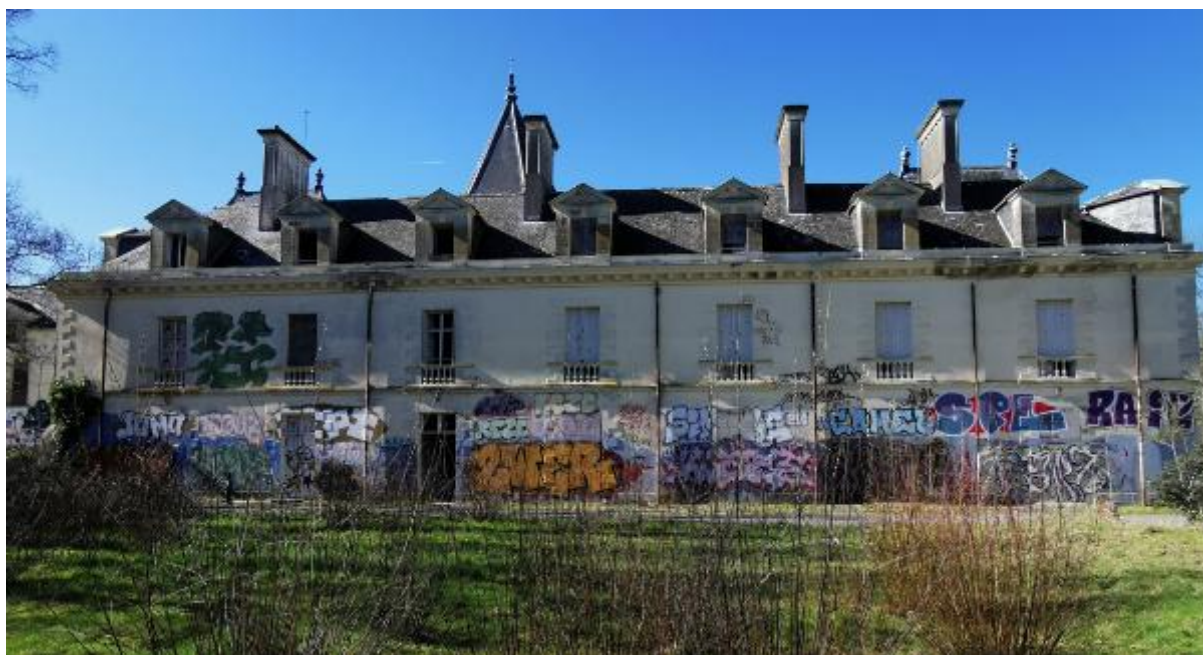
Photo 16 : façade est du château (P Péron – février 2026)
