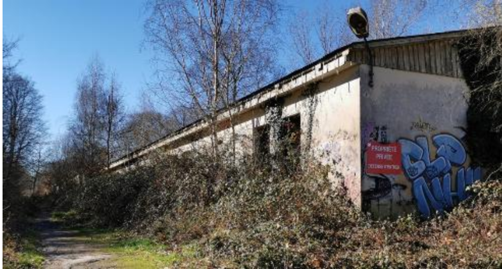
Photo 8 : bâtiment abritant des chiroptères près de l'entrée-sortie de la ZAC (P Péron, février 2026)
