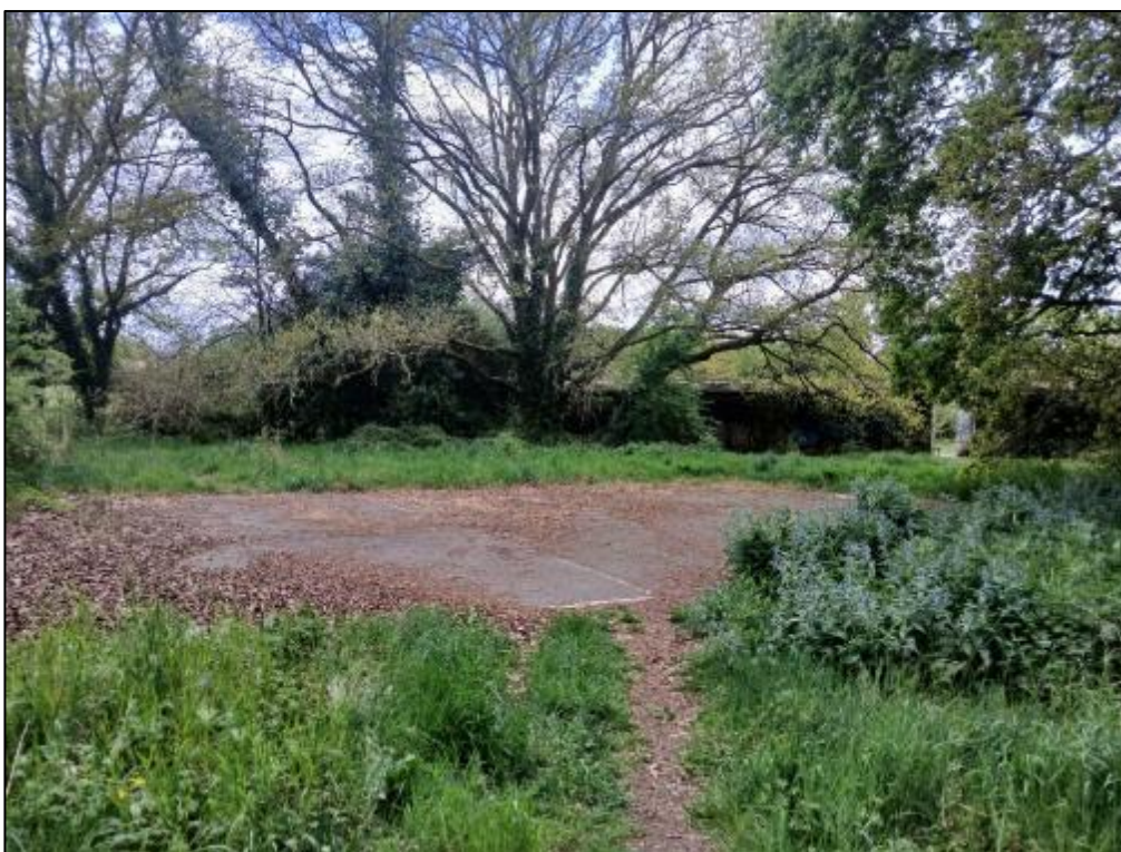
Photo 42 : vue du terrain de basket (1) à désimperméabiliser (Dervenn)
