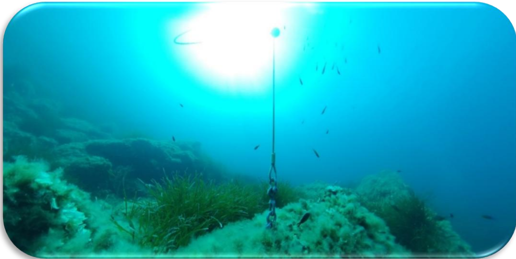
Figure 3 : Mouillage de type « tirant dans la roche » mis en place à Calcatoggio
