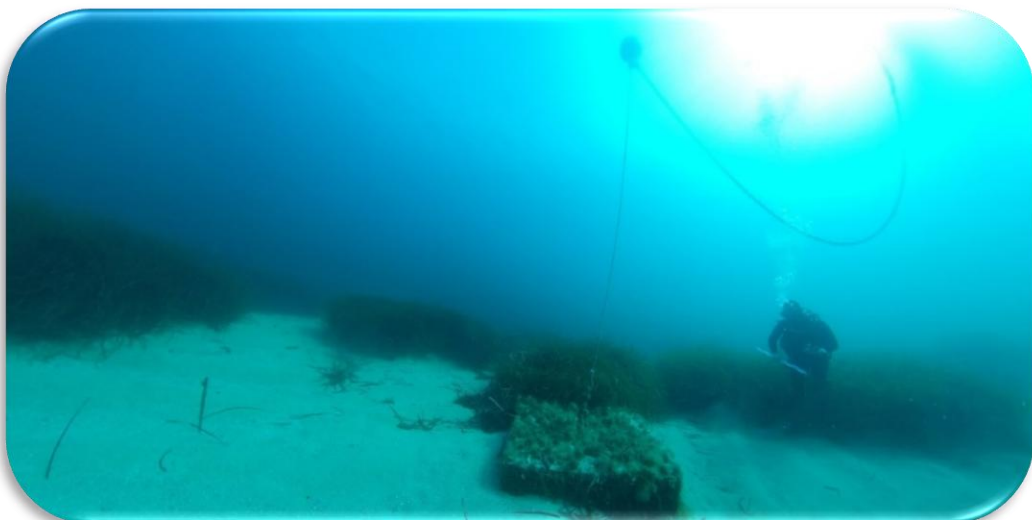
Figure 5 : Mouillage de type « corps-morts » mis en place à Calcatoggio
