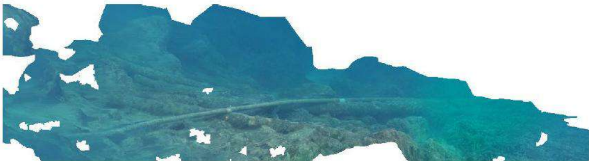
Figure 23: Orthophotographie des conduites du rejet - ASOCEAN
