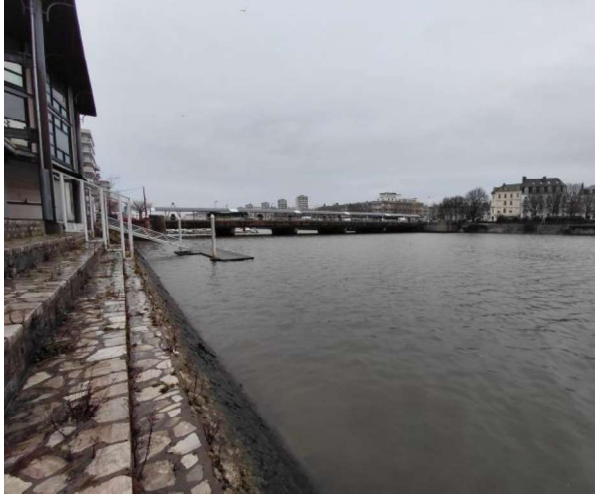
Photographie 3 : Vue depuis le boulevard de Chanzy vers la Liane (Source : Actierra, 2026)
