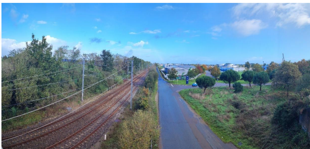
Figure 58 : Voie ferrée et zone d'activité de Dompierre (vue 36 panoramique)
