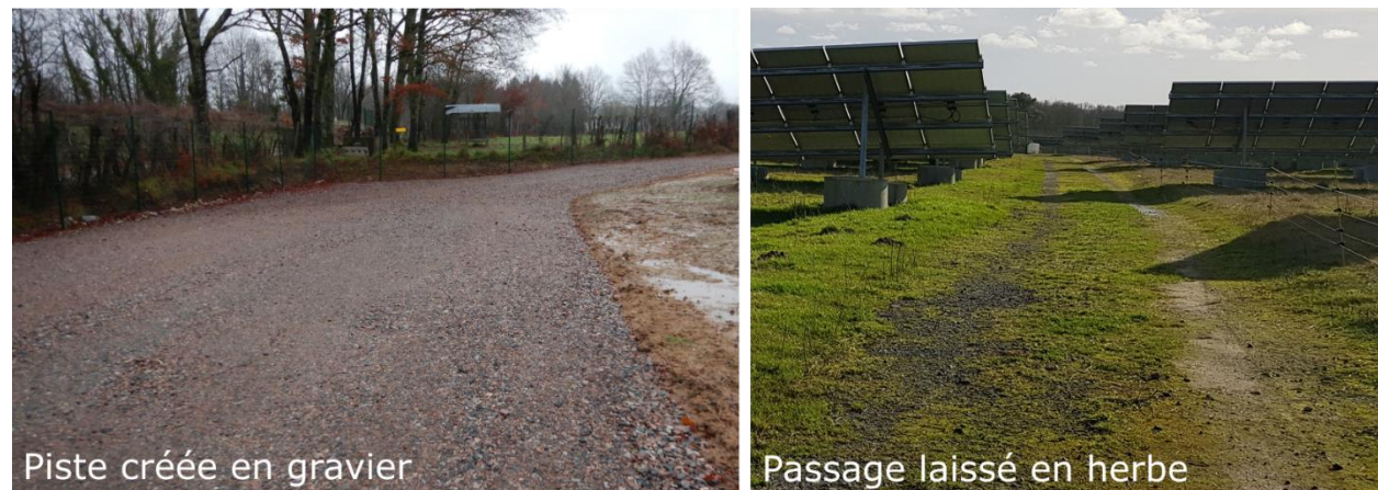
Photographie 7 : Exemple de pistes empierrées et enherbées (Source : ENCIS Environnement)
