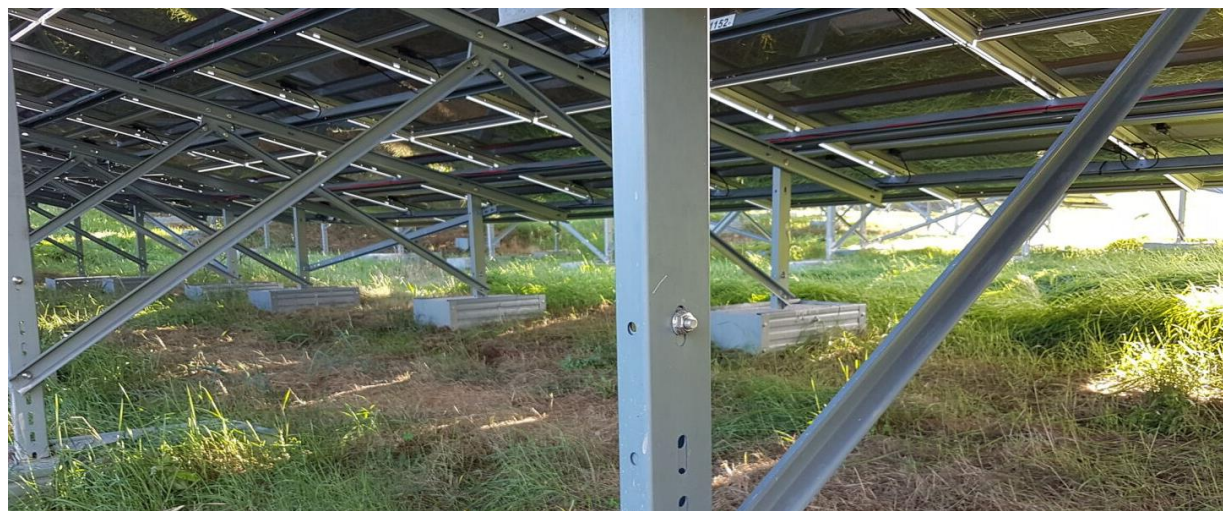
Photographie 5 : Exemple de fixation avec des plots en béton (Source : GDS)
