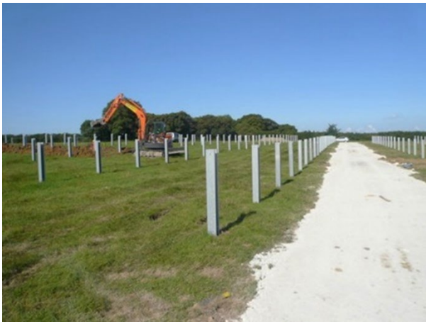
Figure 25 : Exemple de voie d'accès en matériaux concassés
