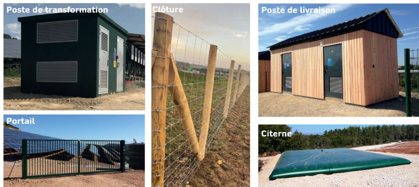
Eléments techniques d'une centrale
