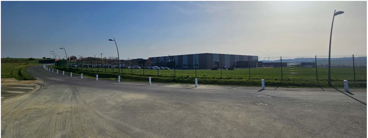
Vue sur le bâtiment existant d'Amphénol Air B depuis la voie de desserte existante de la ZAC
