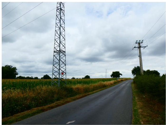
Vue 5 – Lignes électriques traversant la ZIP
