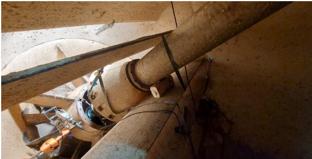
Figure 7 : Kaplan en cours de remontage (été 2023)
