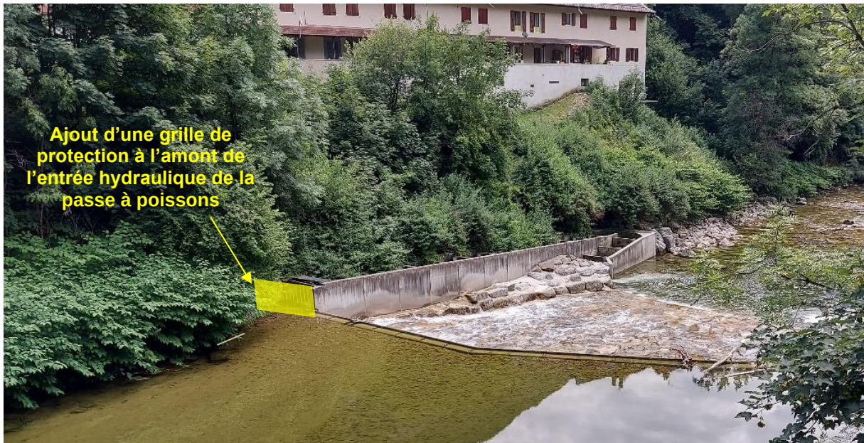
Figure 39 : travaux d'adaptation de la passe à poissons amont
