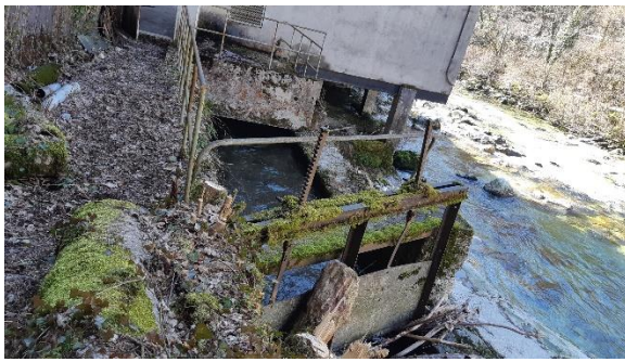
Vannes de garde du canal d'amenée en rive gauche
