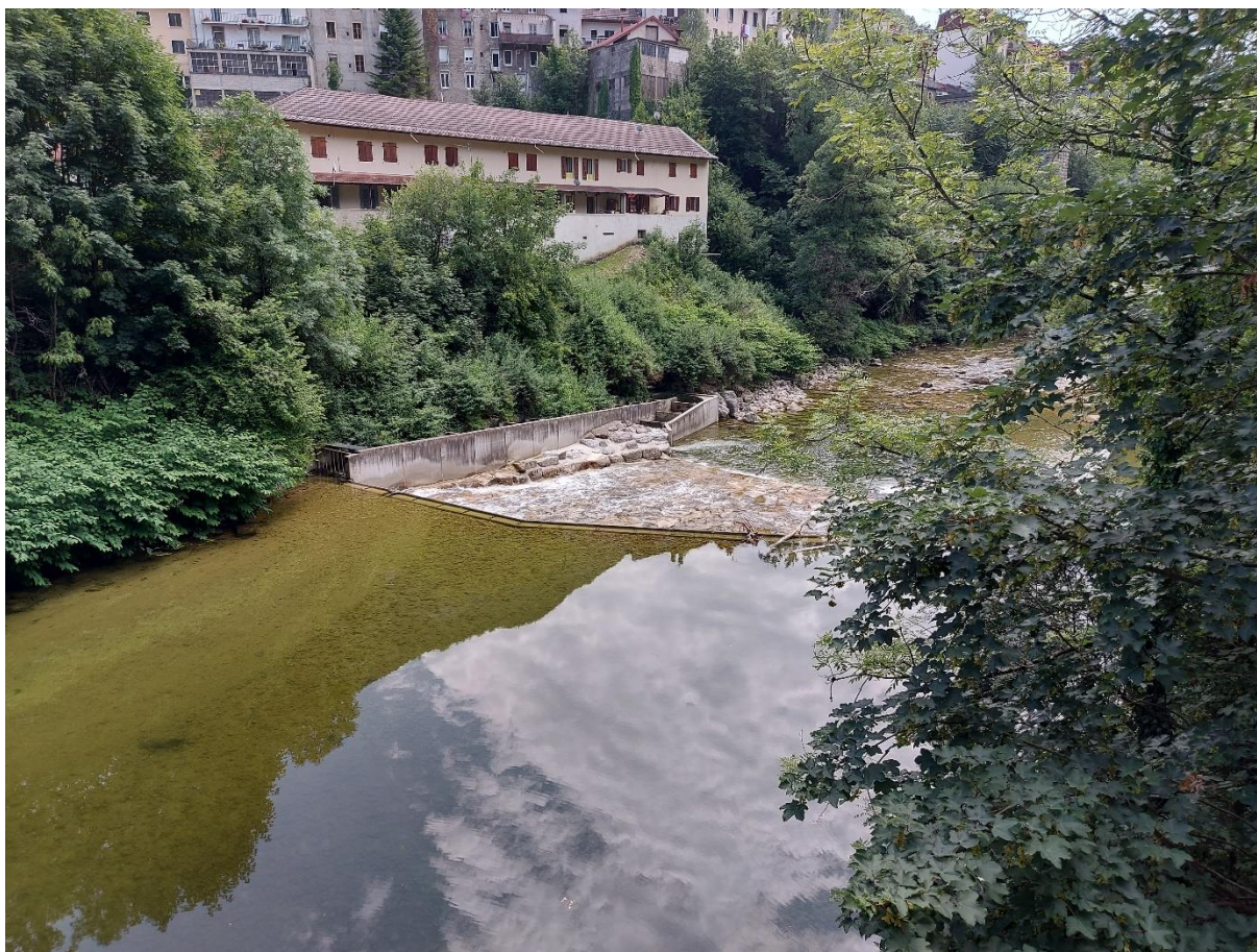
Figure 37 : Photo de la passe à poissons du pont d'Avignon
