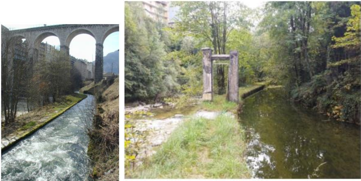
Figure 4 : Vues du canal d'amenée
