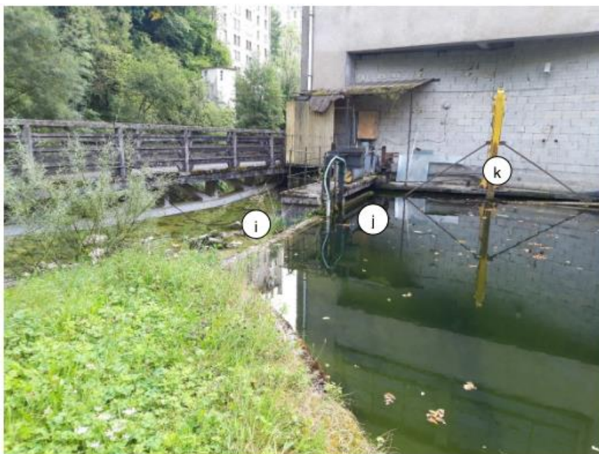
Figure 5 : Vue en amont du bâtiment
