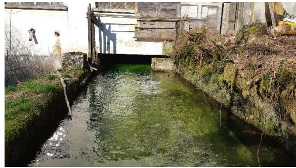
Sortie du canal d'amenée sous les bâtiments en rive gauche
