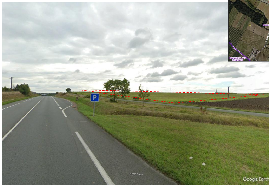
Point de Vue 4 : Vue depuis la RN141. Les haies prévues masqueront les visibilités et préviendront toute gêne de réfléchissement.
