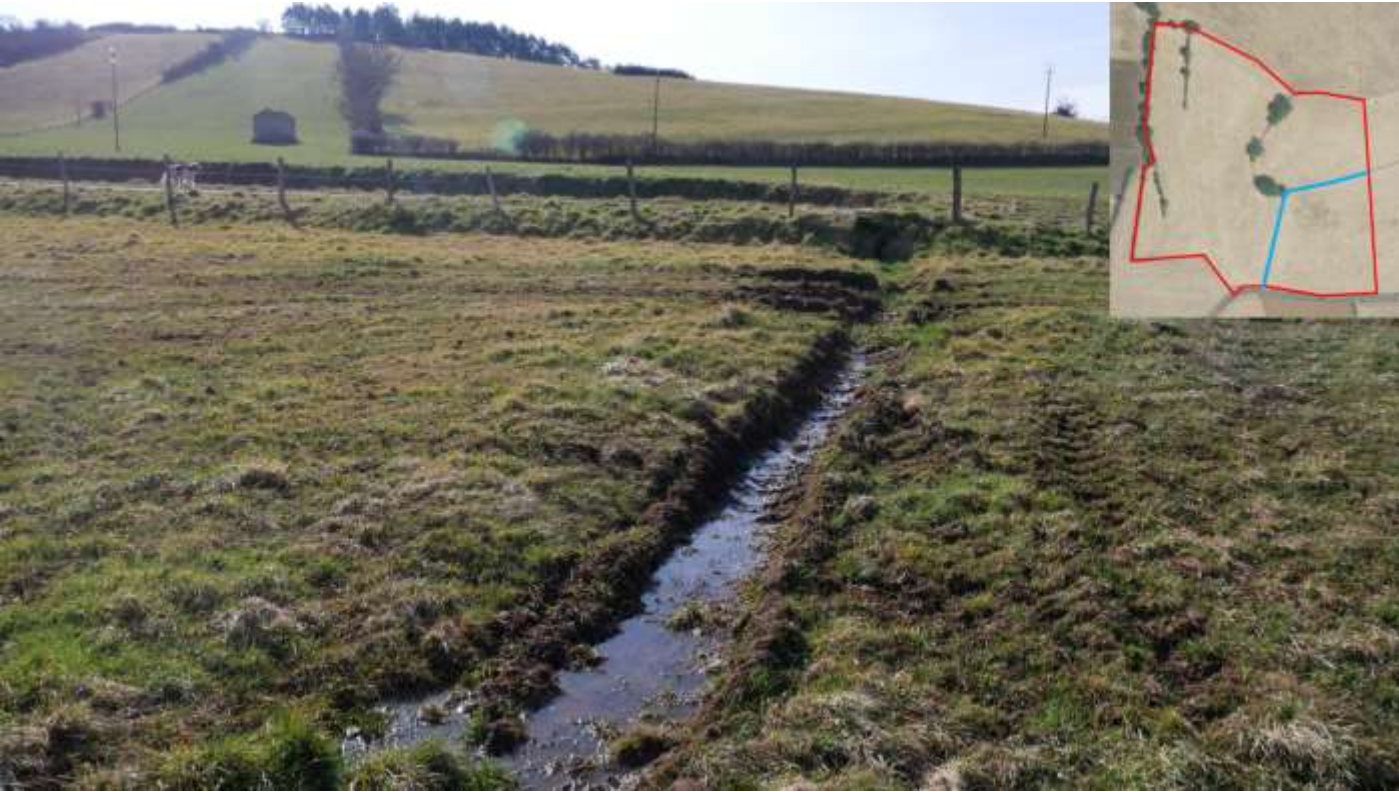
Photographie 3 : Fossé en eau (en bleu) au sein de la ZIP (source : Eco-Stratégie, 20/02/2025)
