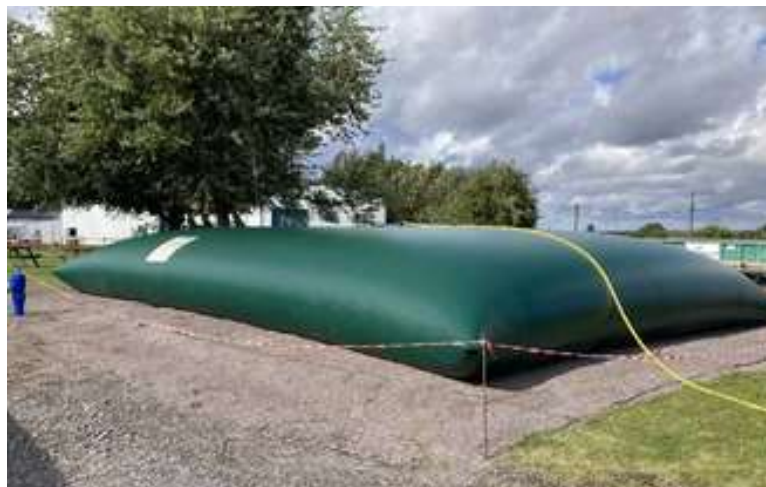
Figure 14 - Citerne incendie souple de 30 m 3 .
