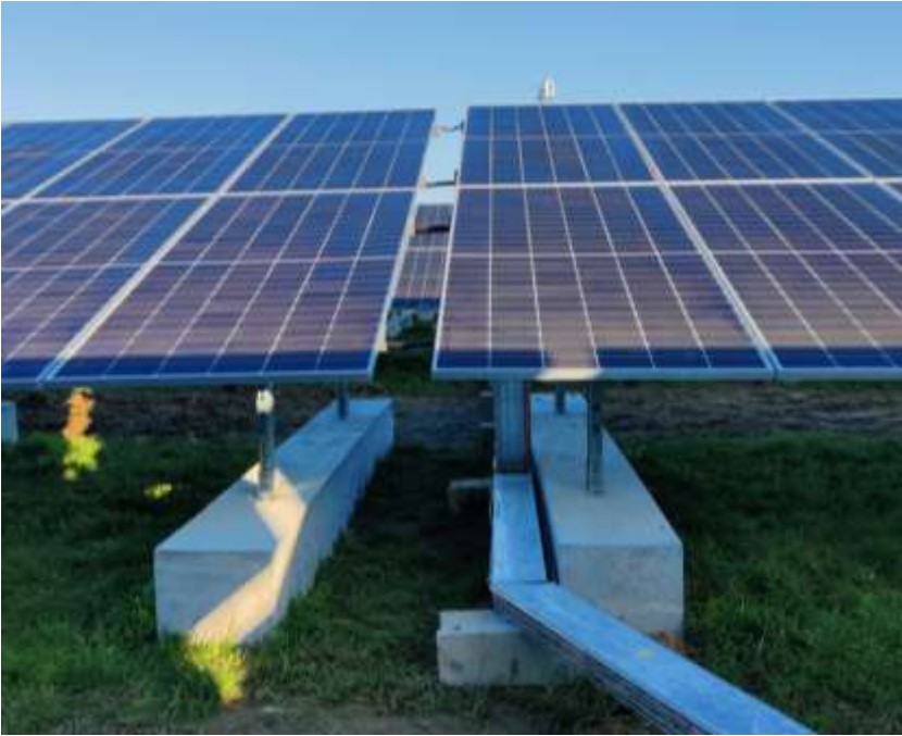
Figure 11 - Longrines bétons sur centrale au sol (Source : NEPSN).
