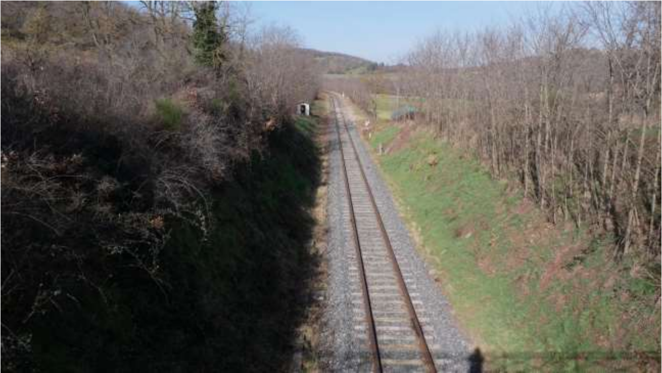
Photographie 10 : Ligne ferroviaire 790 (source : Eco-Stratégie, 20/02/2025)
