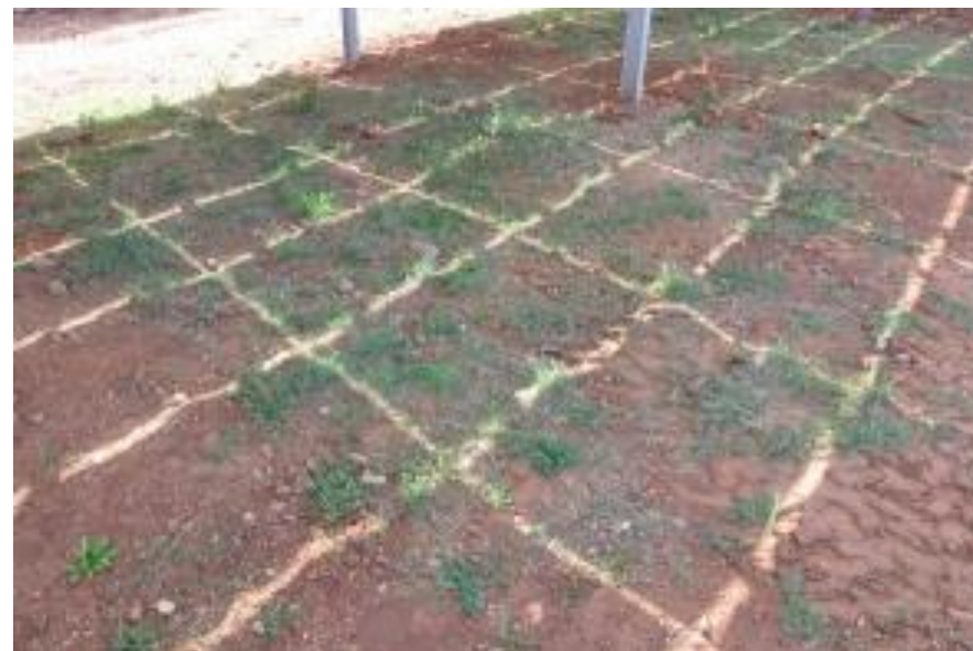
Aperçu de l'ombrage provoqué par les structures d'une centrale photovoltaïque ; notons la présence d'un développement végétal (source : BD ECO-STRATEGIE)
