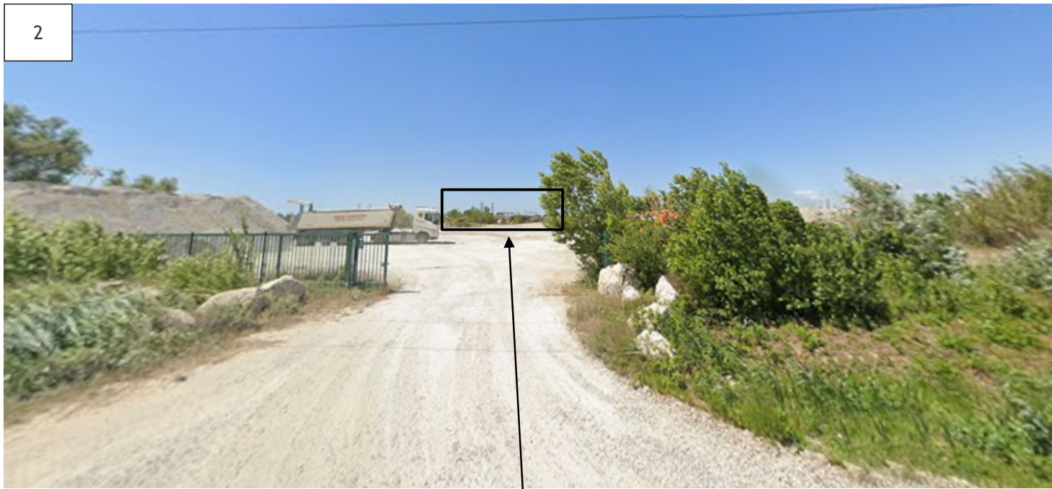
Vue depuis l'entrée du site voisin - Vue éloignée de la solution 1 Google Street View, Mai 2025
