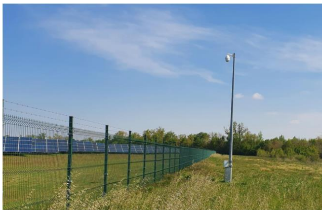
Figure 16. Exemple de dispositif de télésurveillance (caméra sur poteau) mis en place
