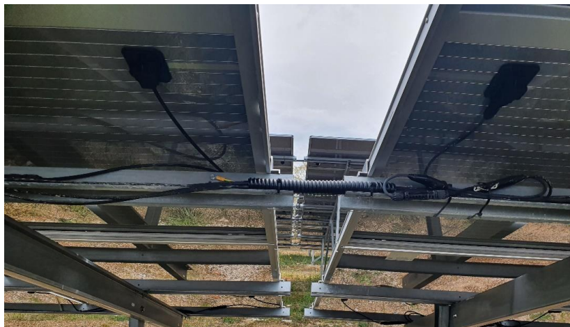
Figure 11. Illustration du raccordement aérien, sous les panneaux
