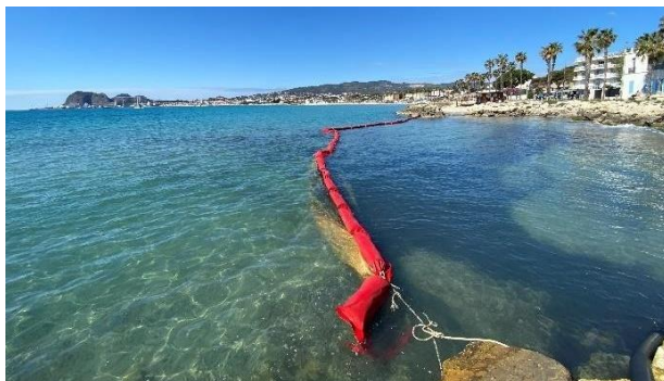
Figure 40 : Exemple de dispositif de confinement des eaux (La Ciotat, 2023)
