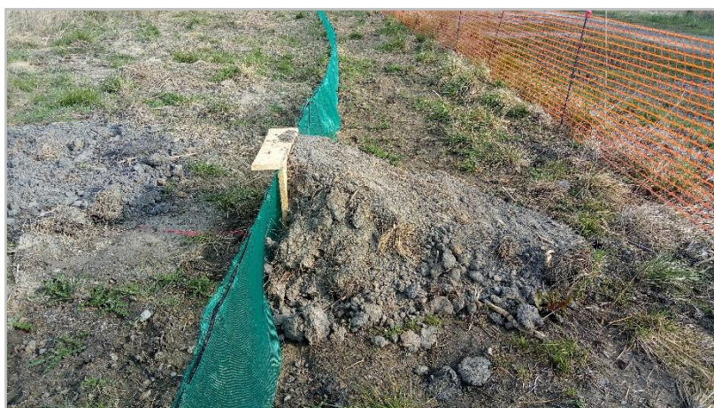
Photo 7 : Barrière à amphibiens et échappatoire © Rainette
