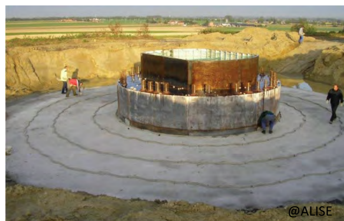
Photo 6 : Durcissement béton
