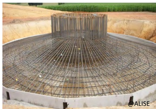
Photo 5 : Excavation et préparation de l'armature
