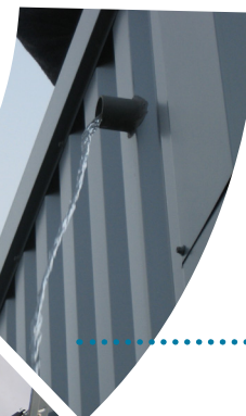
Evacuation canalisée des eaux de pluie *
