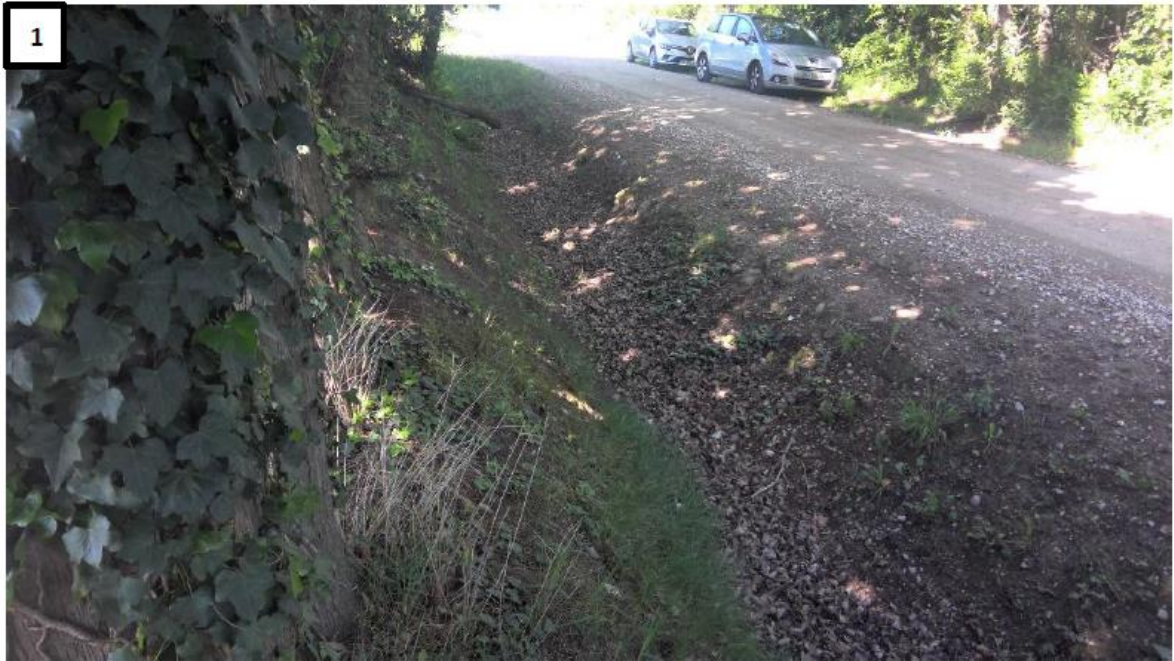
Photo du fossé et du talus séparant la route et la parcelle YR 0001
