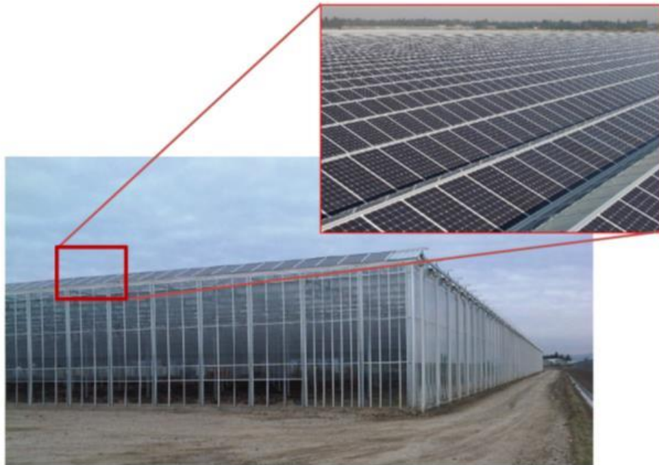
Exemple de serres chapelles et des supports des panneaux
