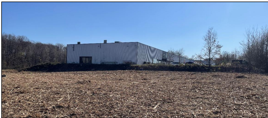
Photo 1 : Zone défrichée – Vue vers le Sud-Est (Source : BE-JC, 18/03/2026)
