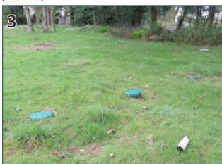
3 Les traces d'un ancien système d'assainissement (épandage). Attention, les fosses septiques ont-elles été déposées ?
