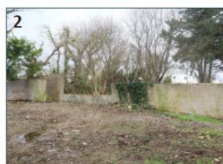
2 Un mur en parpaings au nord de la parcelle (à ouvrir)
