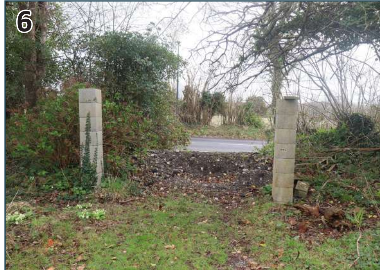
Des piliers à déposer
