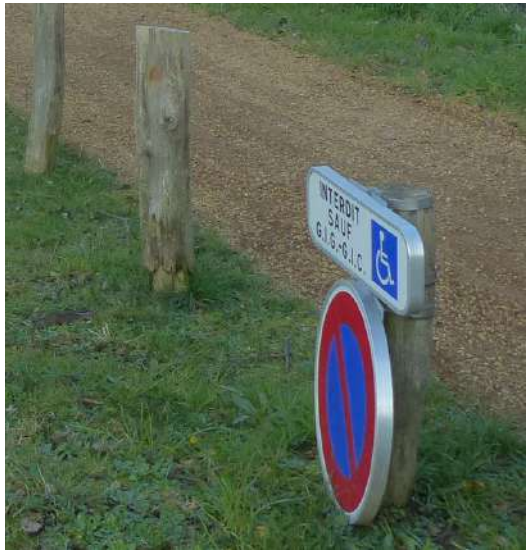
Signalétique Fixée sur piquet de châtaignier
