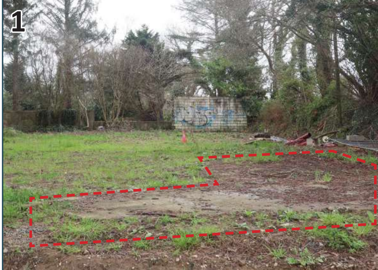
Une dalle béton sur l'emprise du futur chemin piéton (à démolir)
