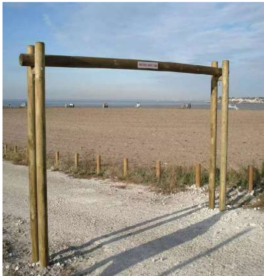
Portique de limitation de hauteur
