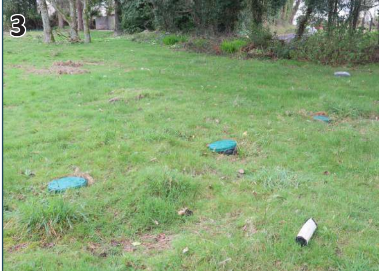
Les traces d'un ancien système d'assainissement (épandage).
