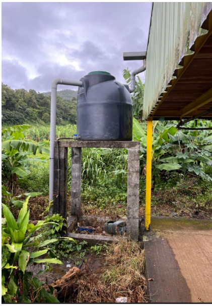
Exemple de systèmes de récupération d'eau de pluie existants (hangar)
